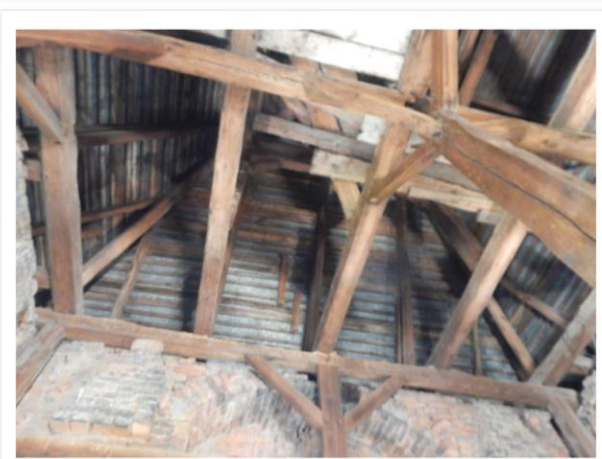
Fot. 6-11. Więźba dachowa wieży
